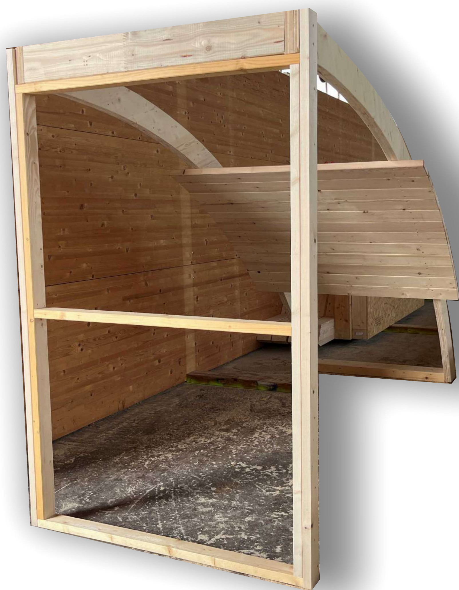
Modell Der Gewölbekonstruktion im Maßstab 1:1
