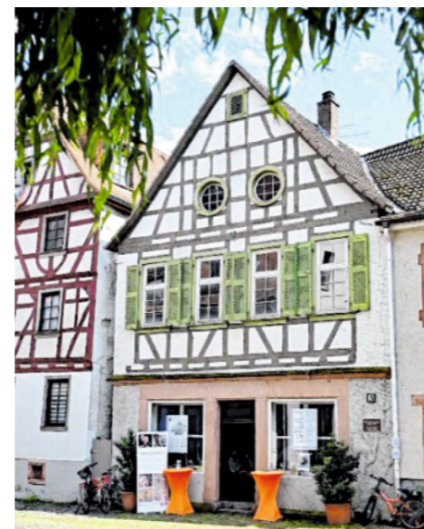
Die alte Synagoge in Heppenheim soll in Stand gesetzt werden. BILD: ERNST LOTZ
