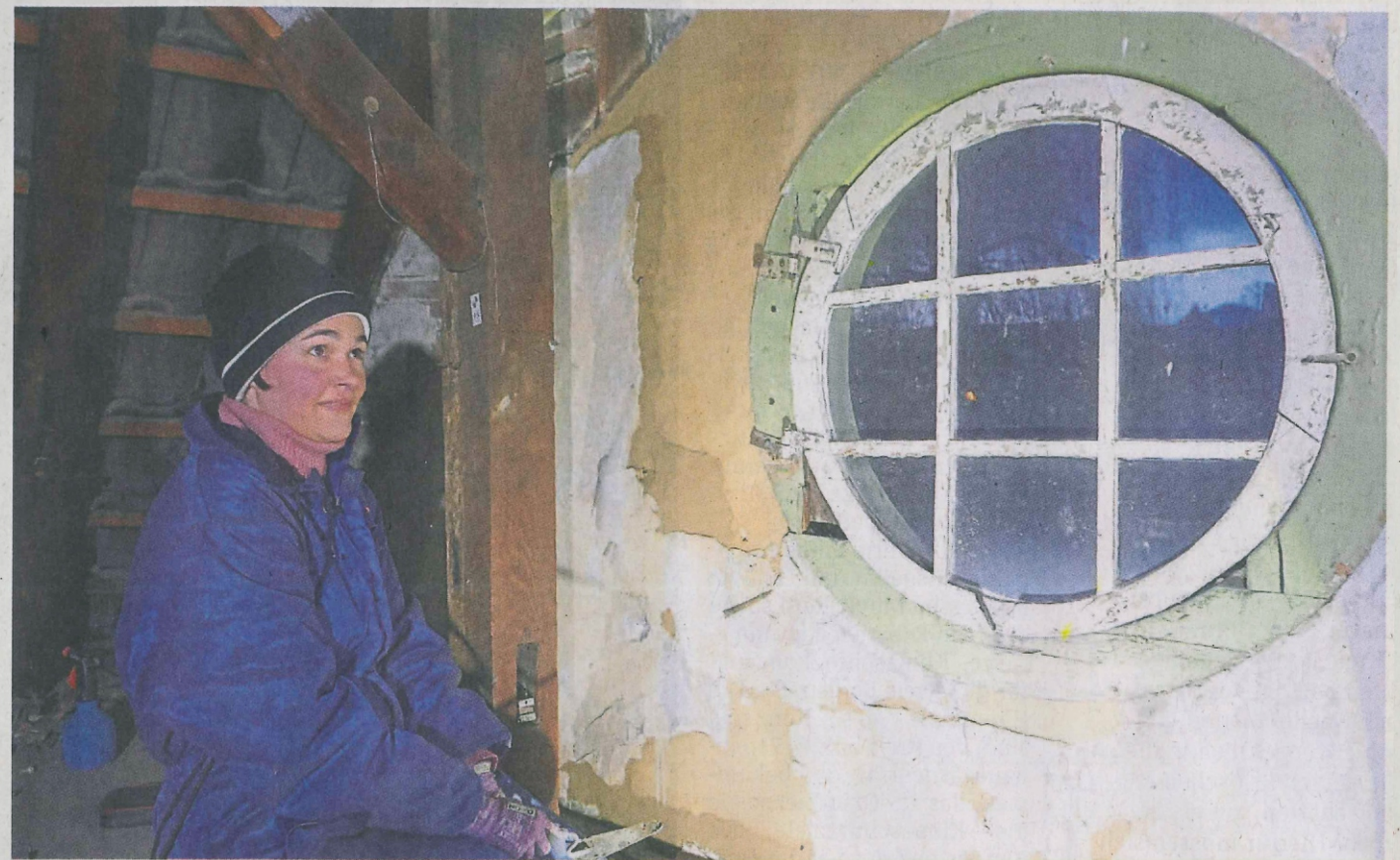
Bei der Arbeit: Diplom-Restauratorin Franziska Müller im Dachstuhl der Alten Synagoge.
